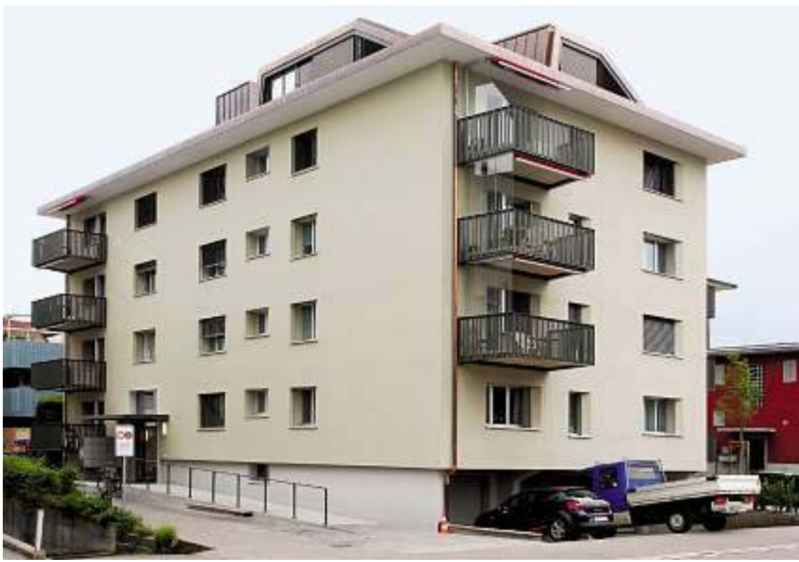
Die neu konzipierten und konstruierten Balkone sowie die neu gestaltete Dachlandschaft werten das frisch renovierte Mehrfamilienhaus an der Emil-Klöti-Strasse 2 auf.
