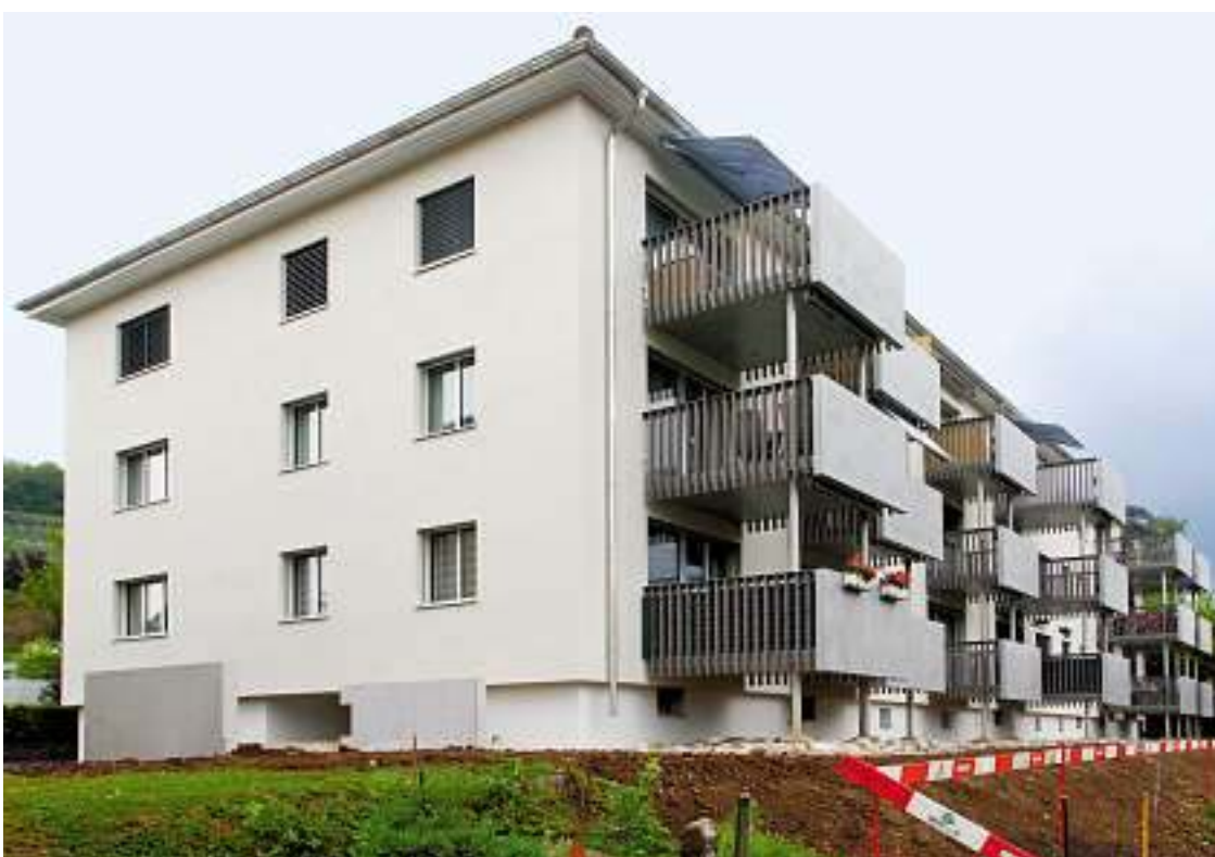
Die neuen, grösseren Balkone bringen den Bewohnerinnen und Bewohnern der Liegenschaft an der Oststrasse 29/31 mehr Lebensqualität.
