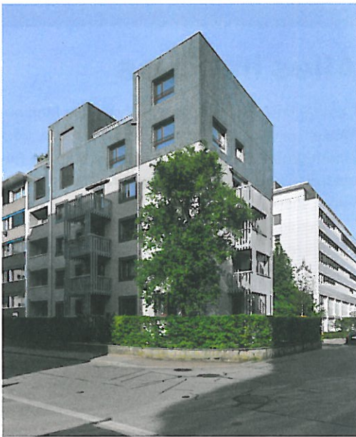
Die zinnenhafte Aufstockung im Plättlikleid verleiht dem Haus wieder Kraft.
